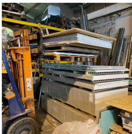
Figura 28 - Processo de sobreposição de pladur.
