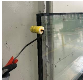
Figura 22 - Passagem do rolo para aperfeiçoar mastic .
