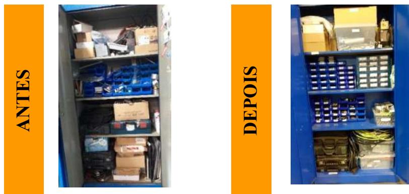
Figura 99. Comparação da situação antes e da situação depois relativa ao armário de materiais de ar condicionado nos setores T3c e T4c.
