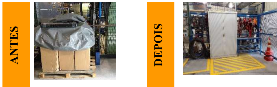
Figura 95. Comparação da situação antes e da situação depois relativa à receção de materiais e armazenamento provisório nos setores T3c e T4c.
