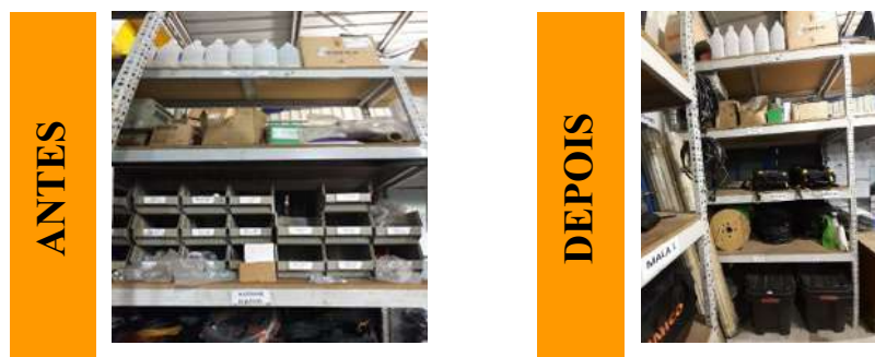
Figura 91. Comparação da situação antes e da situação depois relativa ao armazenamento dos materiais nos armários do setor T2c.
