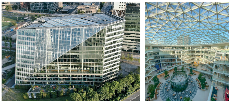
Aspetto exterior e interior do edifício The Edge . (Fonte: https://edge.tech/developments/the-edge )
