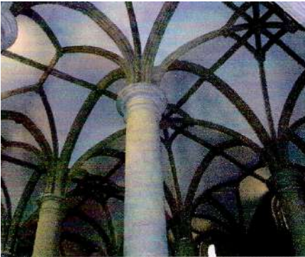
Fig. 92 - Igreja Matriz (cobertura abóbada-da polinervada)
