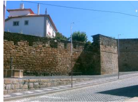
Fig. 24 - Restos da muralha ainda hoje existentes
