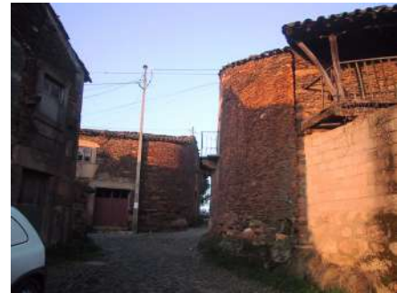
Fig. 56 - Construções cujas suas paredes se encontram arredondadas
