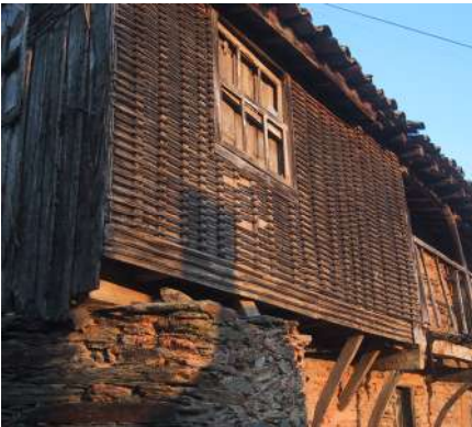
Fig. 55 - Sistema construtivo conhecido por tabique
