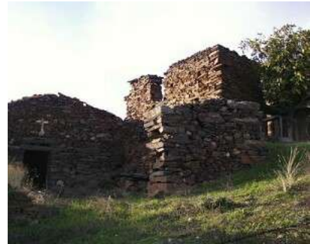
Fig. 48 - Arquitectura demonstrativa da relação da obra com os materiais do lugar
