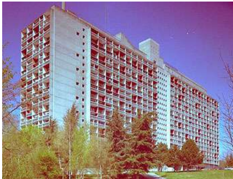
Figura 7: França, Marselha _ Unidades de habitação
