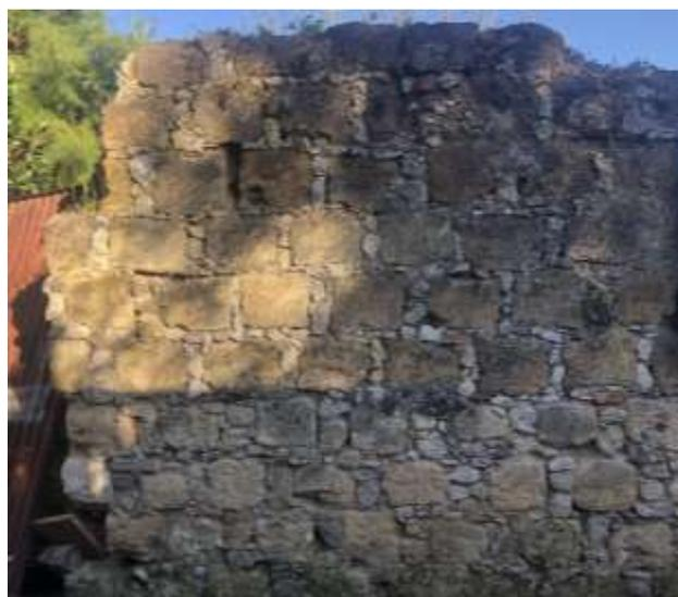
**Ilustração 52** – Muro de tufo calcário aparente na atualidade. (Ilustração nossa, 2021)
