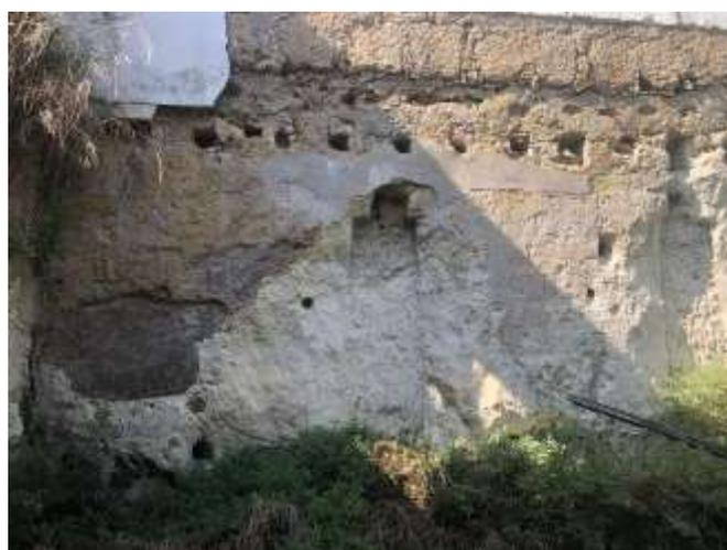
**Ilustração 61** – Perfuração de tufo calcário para colocação de vigas. (Ilustração nossa, 2021)
