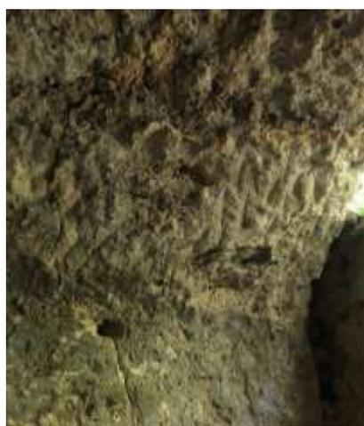
**Ilustração 28** – Marcas de ferramenta para apartamento de uma gruta. (Ilustração nossa, 2021)
