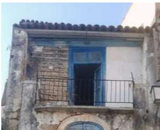
**Ilustração 81** – «Sobradinho» com parede em tabique. (Ilustração nossa, 2021)
