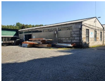
Figura 4 - Instalações da empresa Armindo Gouveia Serralharia
