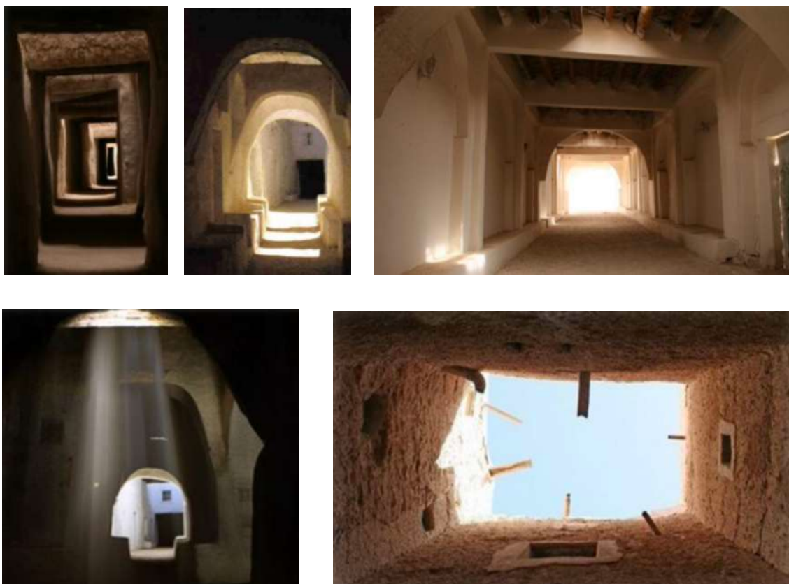
Ilustração 8 – Método de distribuição de luz solar. (Alabid et. al. , 2015, p.8).
