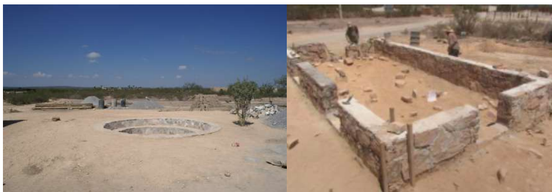
Ilustração 56 – Fotografias do início da obra. (TOA, 2020)
