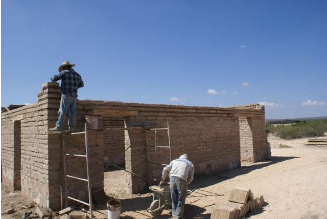
Ilustração 57 – Durante a construção das paredes em adobe. (TOA, 2020)
