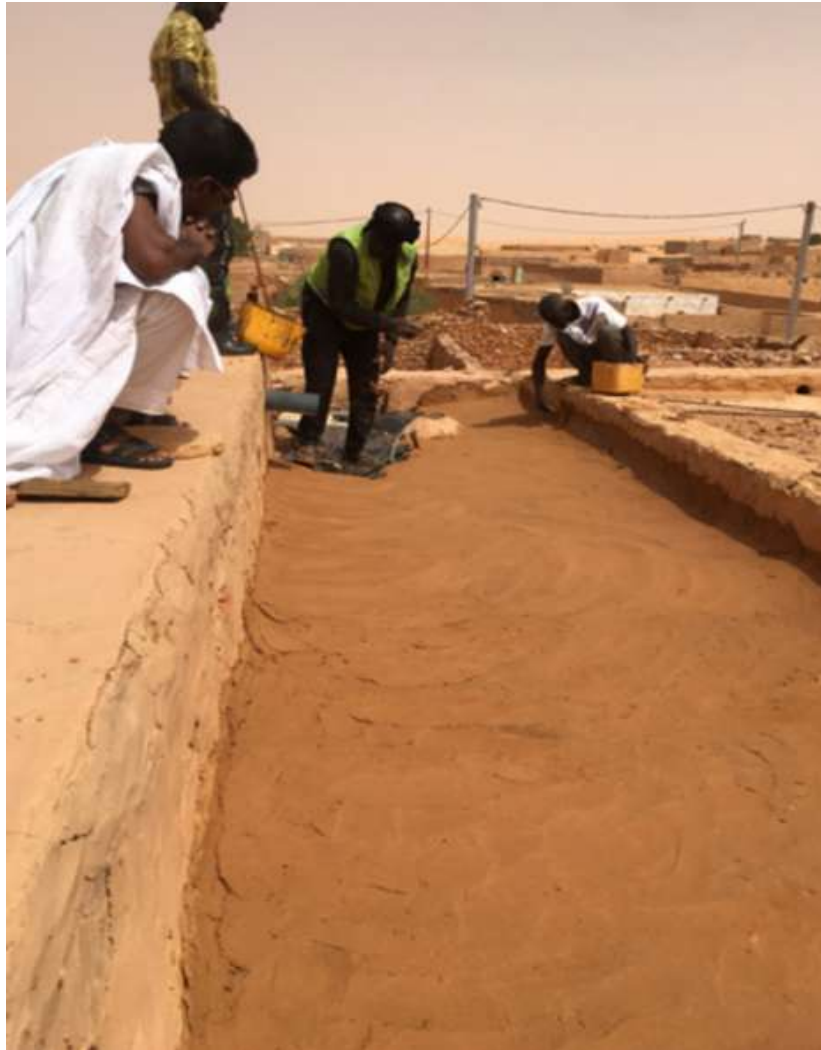
Ilustração 41 – Restauro da cobertura
