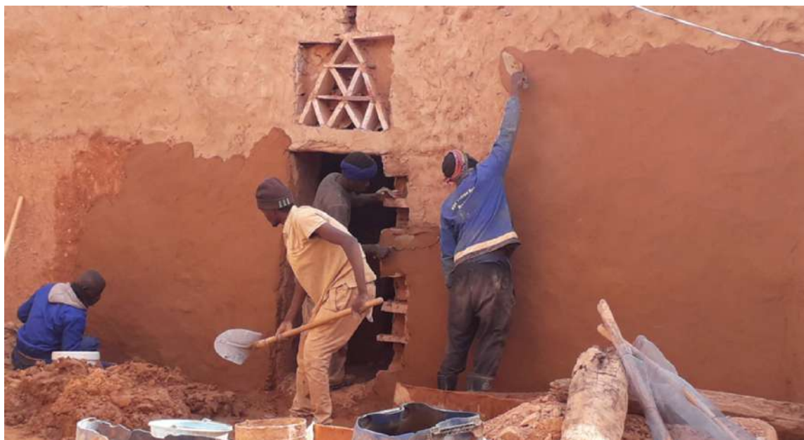
Ilustração 39 – Fotografia do trabalho de restauro da fachada numa das bibliotecas. (Terrachidia, 2020)
