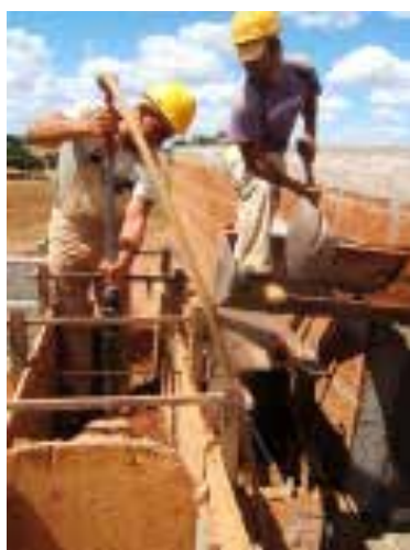
Ilustração 17 – Execução de taipa com compactador pneumático, obra em Serpa. (Betão e taipa, 2020).
