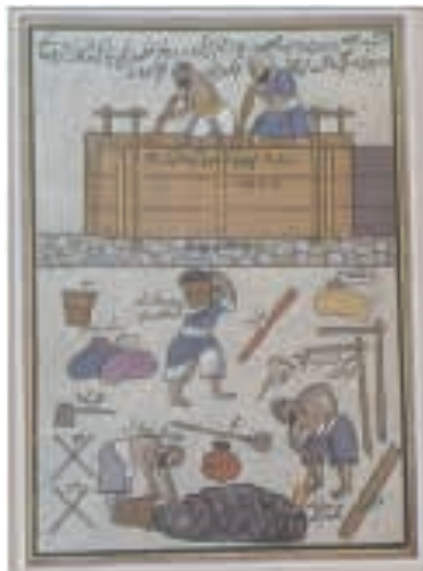
Ilustração 13 – Manuscrito com pormenores da construção em taipa, Jaquin, 2008. (Torgal, Eires e Jalali, 2009, p. 12).
