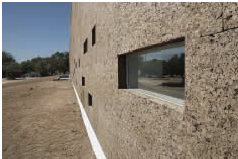
Ilustração 132 – Edifício com sistema ETICS, com isolamento térmico de cortiça (ICB) à vista. (Amorim Cork Insulation, 2020).
