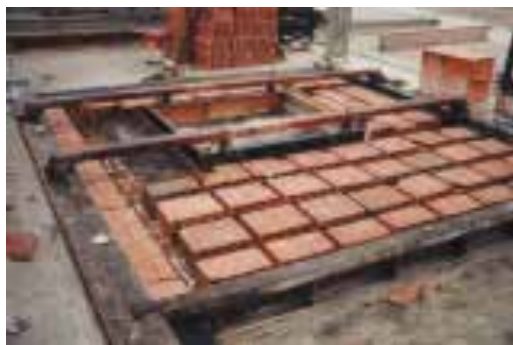
Ilustração 110 – Fase de execução de painel pré-fabricado de parede exterior resistente, ICESA, 1966. (Pinto, 2001, p. 289).
