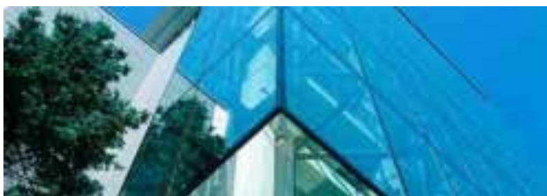
Ilustração 142 – Sistema de parede agrafada com vidro isolado com ponto fixo à folha interna. (Saint-Gobain, 2020).
