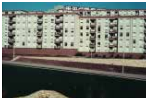
Ilustração 109 – Construção com paredes exteriores pré-fabricadas pesadas de edifícios habitacionais em Santo António dos Cavaleiros, ICESA - SAC, 1967. (Pinto, 2001, p. 300).
