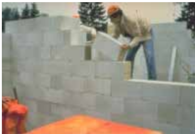
Ilustração 90 – Assentamento de blocos de betão celular em autoclave, Mateus, 2004. (Coelho, Torgal e Jalali, 2009, p. 50).
