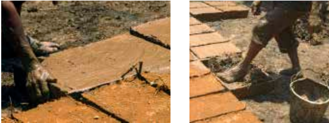
Ilustração 24 – Compactação manual de adobe em molde de madeira, Ignacio Gomez Pulido. (Baraya, 2020).
