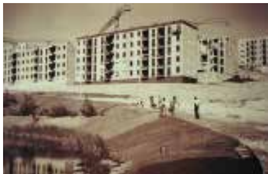
Ilustração 108 – Processo de montagem de paredes exteriores pré-fabricadas pesadas, edifícios em Santo António dos Cavaleiros, ICESA - SAC, 1966. (Pinto, 2001, p. 300).
