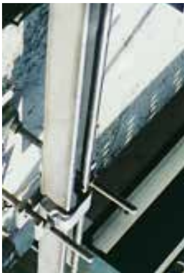
Ilustração 128 – Pormenor de sistema de fixação linear da Halfen usado no edifício MIMA no Reino Unido, 2018. (Halfen, 2020).
