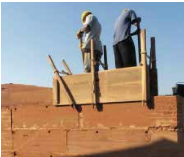
Ilustração 15 – Construção tradicional de parede em taipa, em Moçambique, Miguel Mendes, 2006. (Torgal, Eires e Jalali, 2009, p. 35).
