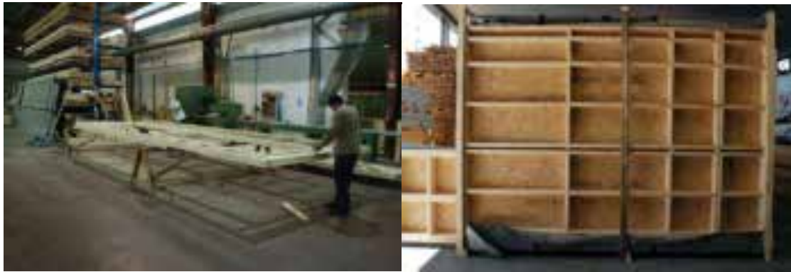
Ilustração 56 – Fabrico de painéis pré-fabricados para sistema aligeirado, Rusticasa. (Laboratório Nacional de Engenharia Civil, 2011, p. A5.15)
