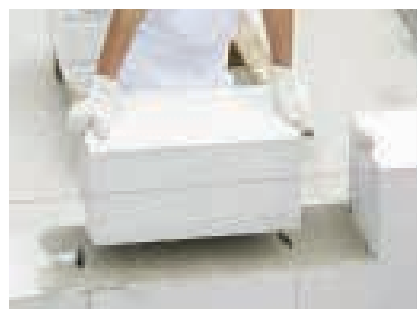
Ilustração 94 – À esquerda, bloco de betão celular autoclavado com pegas - sistema de encaixe macho-fêmea, à direita, assentamento de ACC com pegas em parede exterior de enchimento. (Xella - Ytong, 2020).
