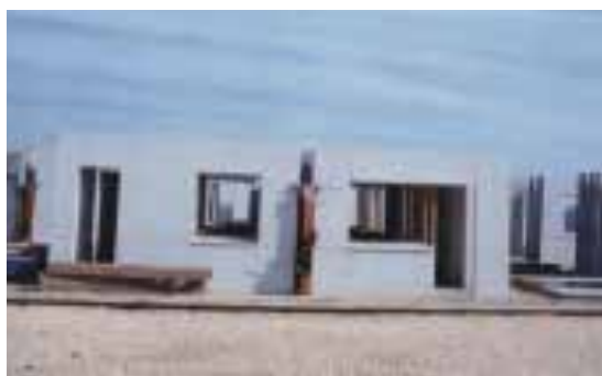
Ilustração 112 – Zona de armazenamento dos painéis pré-fabricados de paredes exteriores resistentes, ICESA, 1968. (Pinto, 2001, p. 290).
