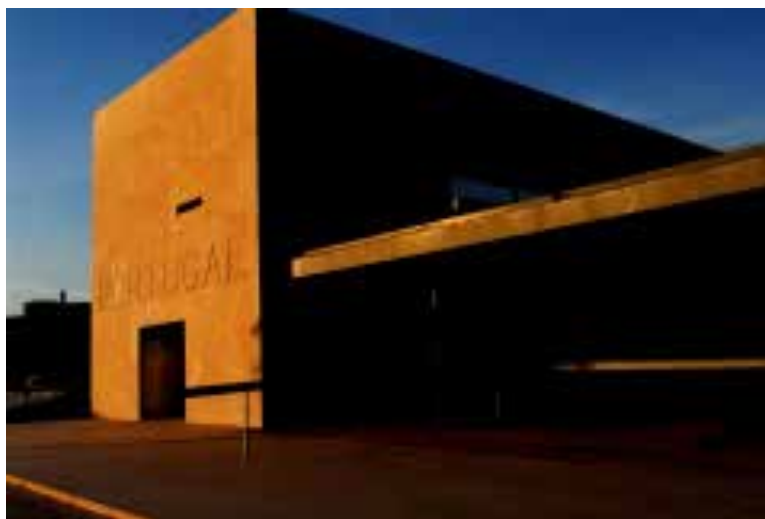
Ilustração 139 – Pavilhão de Portugal na Expo 2000 Hannover, projecto dos arquitectos Siza Vieira e Souto Moura, com sistema ETICS nas paredes exteriores, com placas de aglomerado de cortiça à vista. (Associação Portuguesa da Cortiça, 2018).
