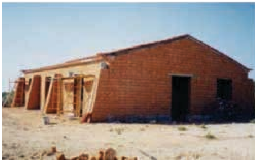
Ilustração 30 –Edifício com paredes exteriores em blocos de adobe no Algarve, Mateus, 2004. (Coelho, Torgal e Jalali, 2009, p. 62).
