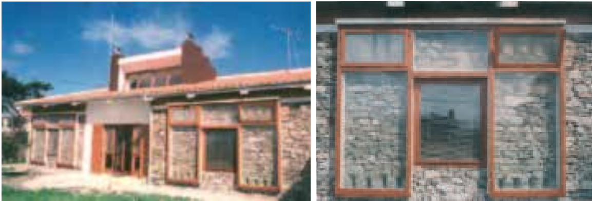
Ilustração 154 – Paredes de Trombe ventiladas na Casa Schäffer no Porto Santo, projecto do Arq. Günther Ludwig. (Gonçalves, H. e Graça, 2004, p. 36).
