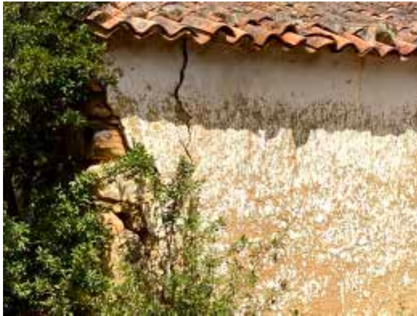
Ilustração 42 – Paredes em alvenaria de pedra ordinária rebocada. (Ilustração nossa, 2020).
