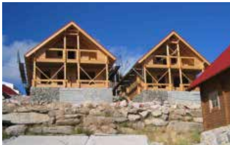
Ilustração 67 – Casas de madeira na Serra da Estrela., Luís Morgado, (Laboratório Nacional de Engenharia Civil, 2010b, p. 158).
