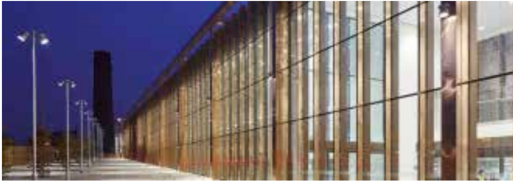
Ilustração 143 – Sistema de parede cortina com vidro flutuante desligado do montante de alumínio , modelo VS-1. (Saint-Gobain, 2020).
