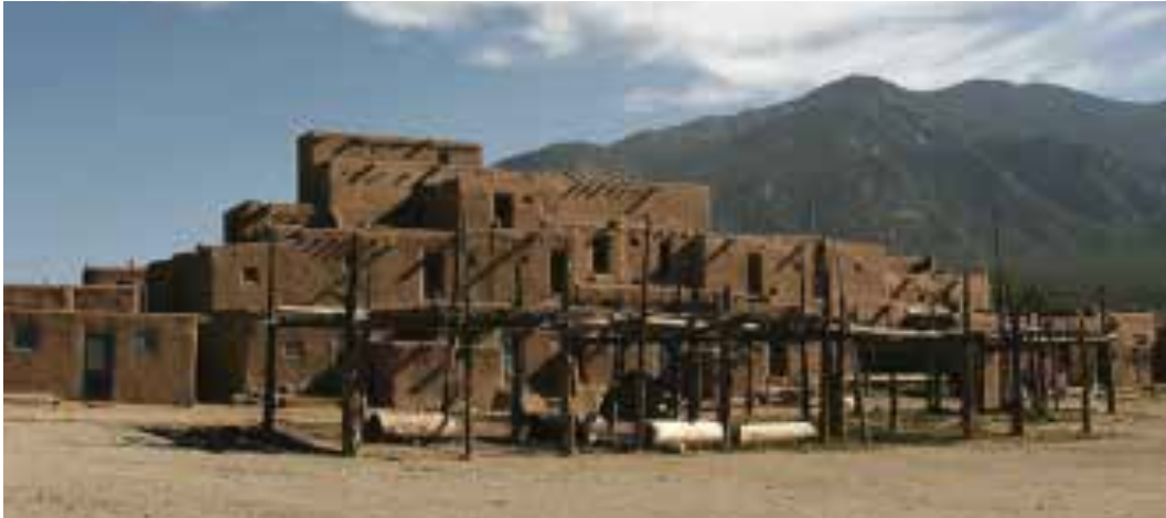
Ilustração 10 – Edificações em terra, Taos, Novo México. (Torgal, Eires e Jalali, 2009, p. 13).
