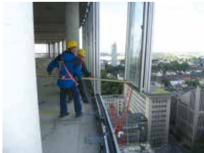
Ilustração 147 – Montagem de elementos pré-fabricados em vidro no sistema de fixação mecânico de cortina. (Halfen, 2020).
