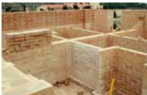
Ilustração 39 – Construção de alvenarias com BTC no Alentejo. (Coelho, Torgal e Jalali, 2009, p. 64).
