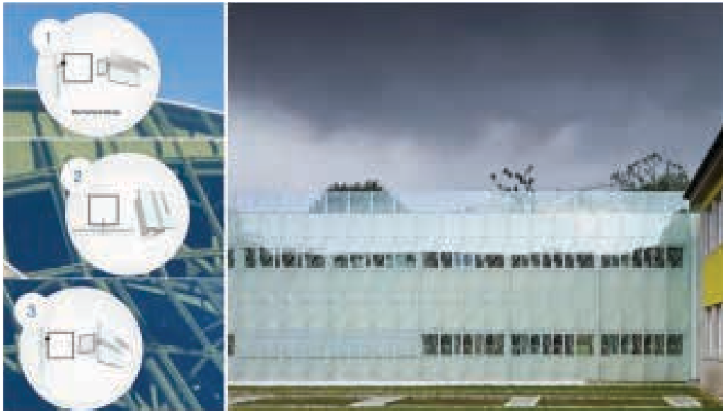
Ilustração 145 – Escola Secundária Alves Martins, em Viseu, com sistema de fixações mecânicas ocultas e silicone estrutural para fixar o vidro encapsulado. (Pentagonal, 2019).
