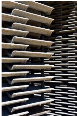
Figuras 113 e 114 | Celosias - Paredes do pavilhão elaboradas com telhas de cimento.
