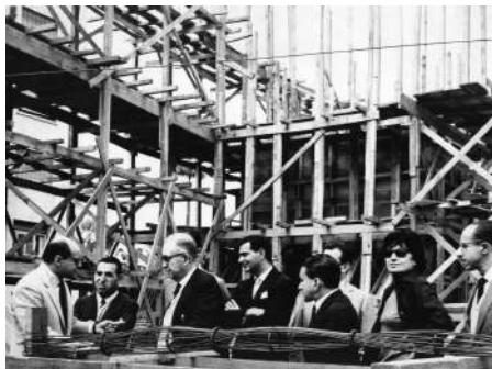
Figura 89 | Lina Bo Bardi na obra, ao lado do 'cavelete de cristal' que desenha para o MASP; Figura 90 | Lina Bo Bardi no contacto direto com os engenheiros; Figura 91 | Engenheiro da obra, Figueiredo Ferraz, explica a estrutura aos presentes - 1963.
