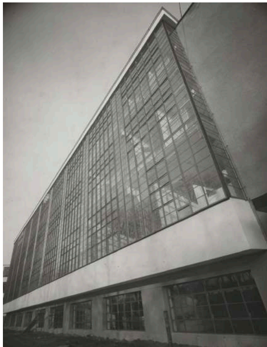
Fig. 62 | Fotografia de Lucia Moholy - edifício da Bauhaus visto de baixo, oblique view - 1926.
