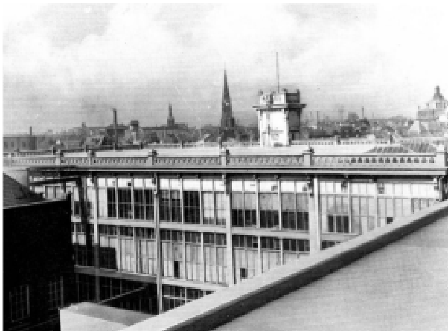
Ilustração 2 – Fábrica Charles VI em Tourcoing, destaque da área envidraçada possibilitada pelo sistema Hennebique. (France. Ministère de la Culture. Médiathèque de l'Architecture et du Patrimoine, 1963).
