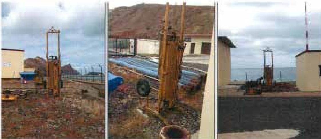
Ilustração 40 – Equipamento Nordmeyer utilizado nos ensaios geotécnicos – imagens correspondentes aos três ensaios efetuados em julho de 2016. (Geocontrole, 2016, p. 3).
