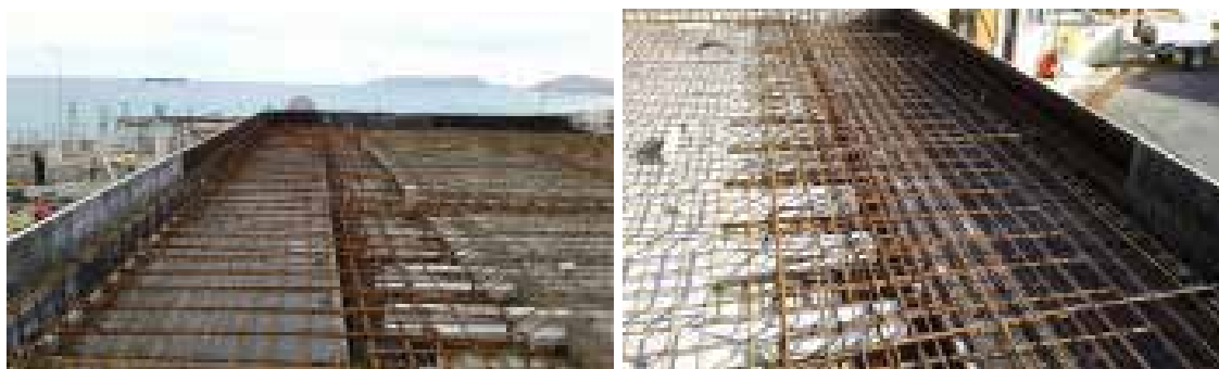
Ilustração 51 – Armação do aço da cobertura do telheiro onde se pode verificar a diferença de cota da malha superior na zona das abobadilhas e ao lado a ação corretiva em execução. (Ilustração nossa, 2017).
