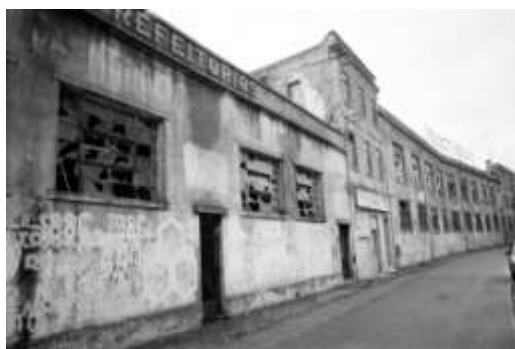
Ilustração 47 - Aspeto da fachada principal do edifício dos refeitórios da fábrica Mundet Seixal (Manuel Lima, Seixal, 1995)
