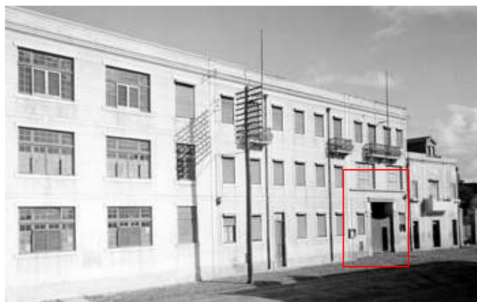
Ilustração 24 - Negativo, de fotografia de autor desconhecido realizada entre 1924 e 1988. Integra o fundo Mundet & Cª Lda. Apresenta imagem com vista geral da fachada principal da fábrica Mundet & Cª Lda. no Seixal (EMS-CDI)
