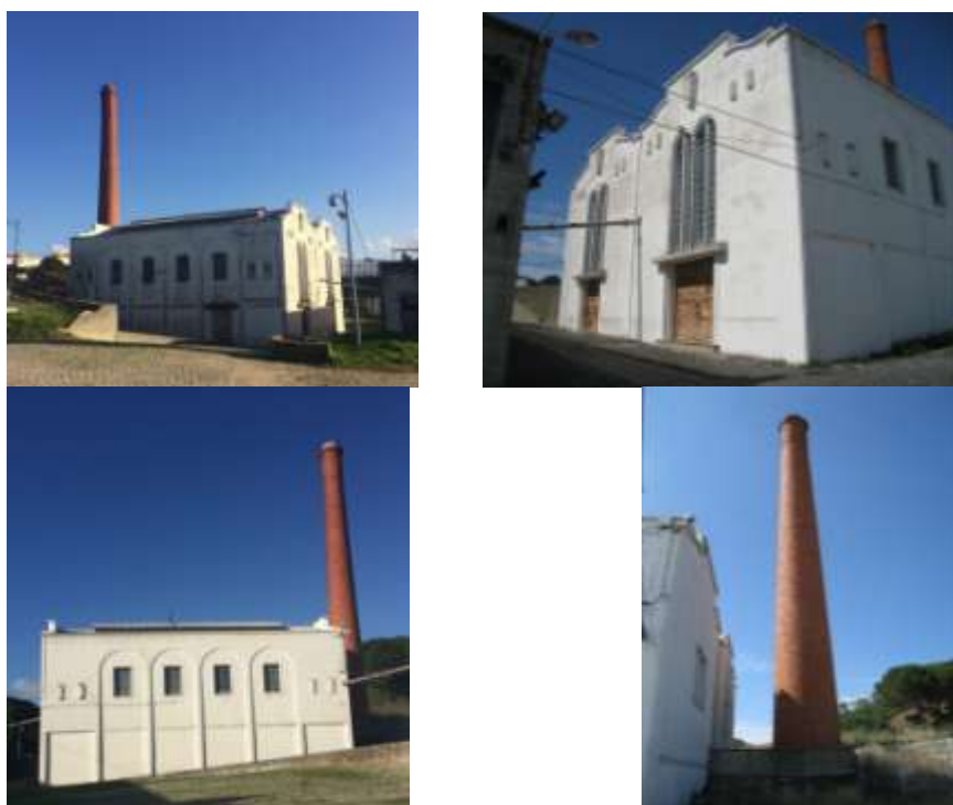
Ilustração 40 - Edifício das Caldeiras Babcock & Wilcox (Ilustração nossa, 2018)
