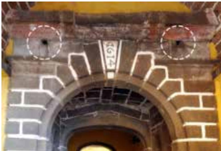
**Ilustração 75** – Orifícios por onde corriam as correntes da ponte levadiça. (Ilustração nossa, 2018).
