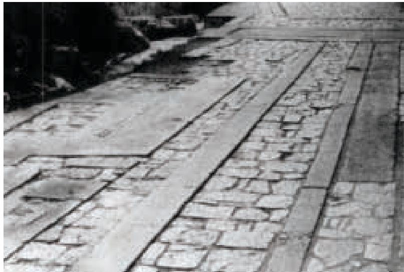
Ilustração 37 - “Detalhe do pavimento do parque da colina Philopapou, Atenas, 1951-1957.” (Frampton, 1998, p. 29)
