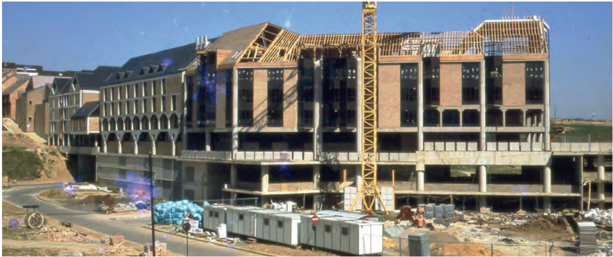
10 - Avanço da construção sobre a laje, dando continuidade aos edifícios da imagem anterior. Os níveis de estacionamento ainda visíveis vão sendo sucessivamente prolongados, até atingirem a encosta em que a laje superior pedonal encontra o terreno natural.
