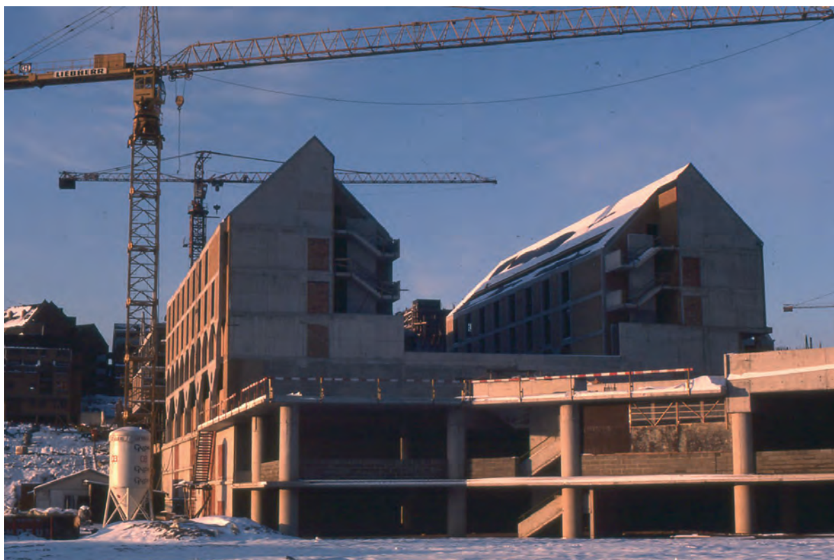
9 - Construção de edifícios universitários em dois volumes opostos, formando uma praça que estabelece, ao nível do peão, a ligação entre as áreas mais habitacionais e o centro.
