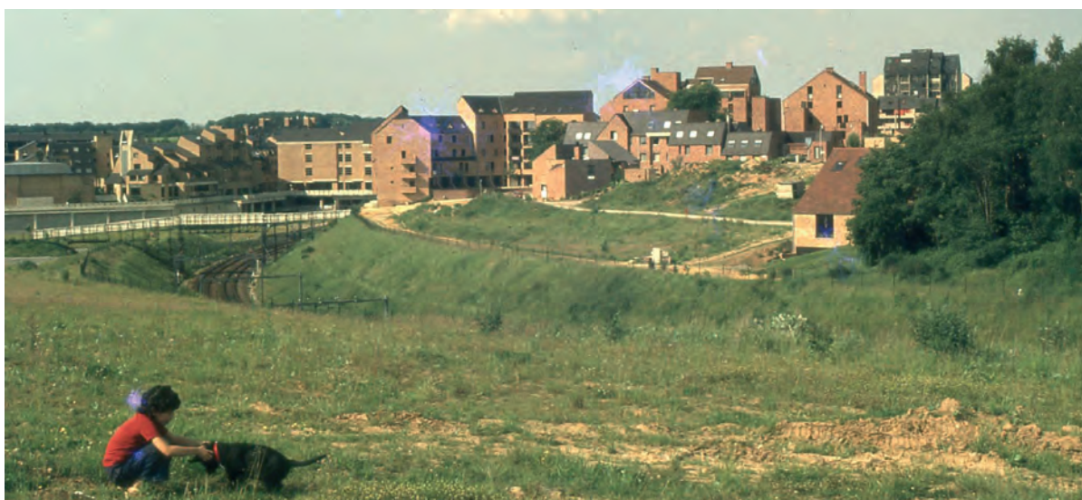
5 - A cidade no começo, vista do exterior. Silhueta urbana inserida na encosta, em ligeiro declive para o vale onde se situa o centro sobre solo artificial. Vê-se ainda um passadiço provisório sobre a linha de caminho de ferro que se dirige ao centro.
