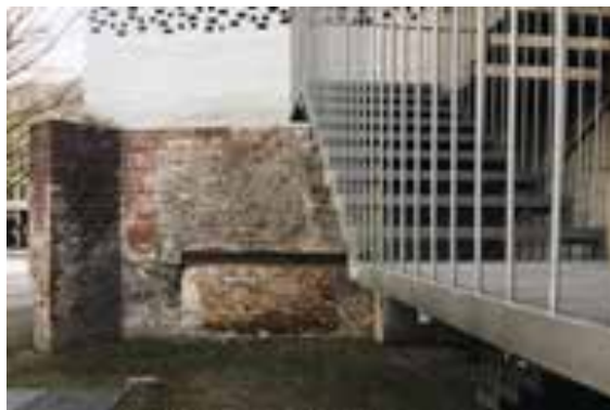
Ilustração 139 Pormenor fachada Museu Kolumba – escadas exteriores. (Ilustração nossa, 2017)
