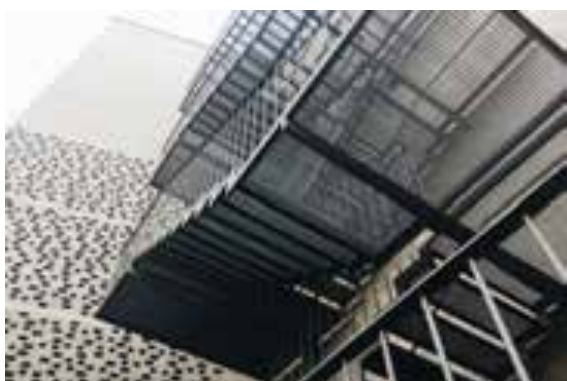
Ilustração 140 Pormenor fachada Museu Kolumba – escadas exteriores. (Ilustração nossa, 2017)
