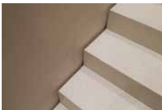
Ilustração 77 Pormenor da escadaria. (Ilustração nossa, 2017)
