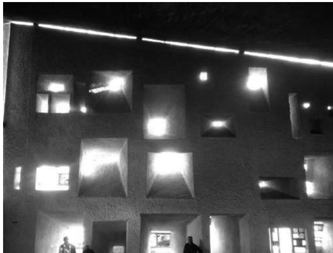
Figura 15 – Capela de Ronchamp – Le Corbusier: efeito de levitação da cobertura provocado pela luz natural.
