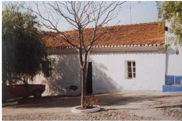
Figura 60 – Casa Conduto, 1999 Fonte: Arquivo Arq. Ana Almeida e Rui Cunha
