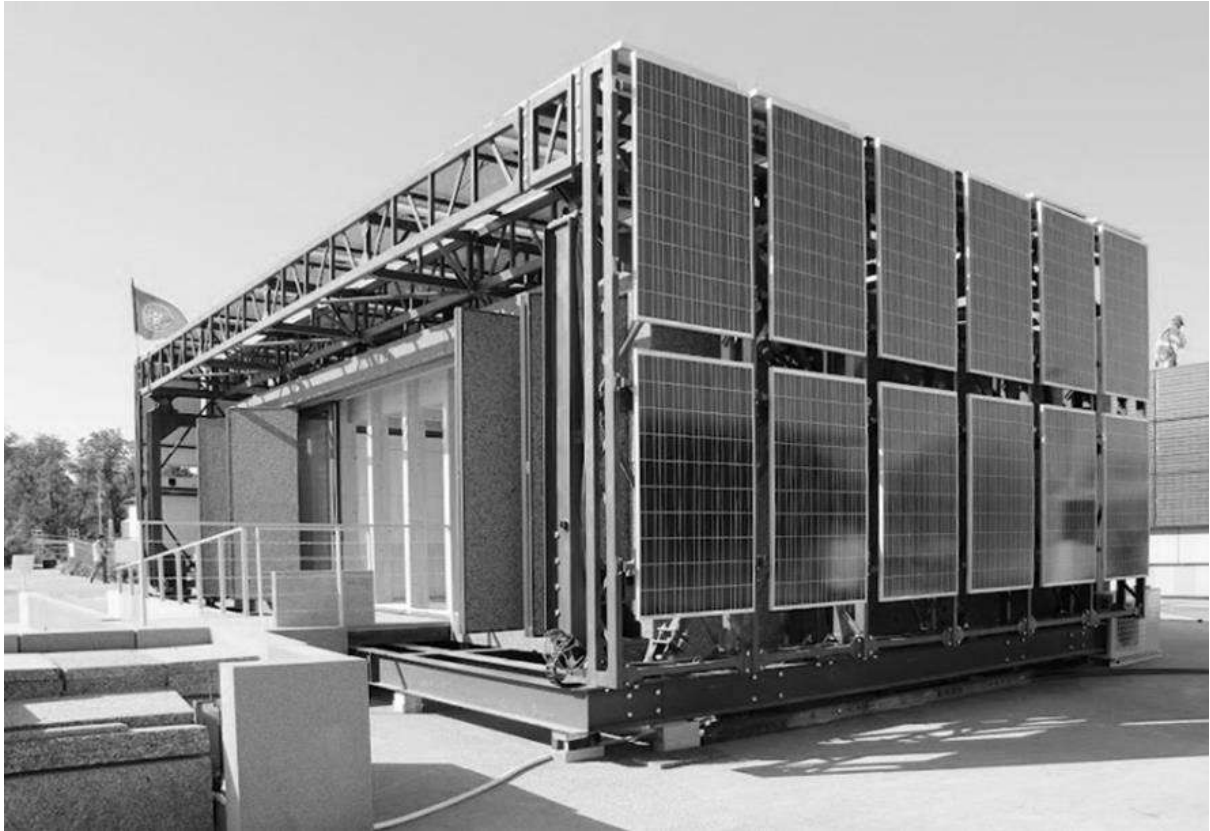
Figura 31 - Fachada da Casa em Movimento revestida a painéis fotovoltaicos Fonte: https://www.designboom.com/weblog/images/images_2/danny/cemnem/cemnem04.jpg
