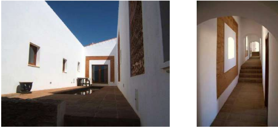
Figura 74 - Casa Cantar do Grilo –corredores interior e exterior Fonte: https://www.facebook.com/Bet%C3%A3o-e-Taipa-Constru%C3%A7%C3%A3o-e-Recupera%C3%A7%C3%A3o-de-Edifícios-Lda-144146382284687/
