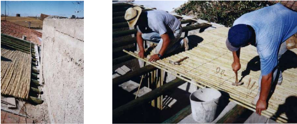
Figura 69 - Casa Conduto – pormenor da reconstrução da cobertura.
