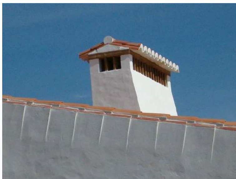
Figura 81 - Pormenor da cobertura
