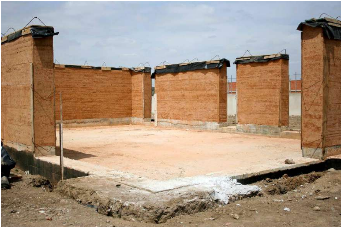
Figura 37 - Pavilhão de Betão e Taipa,
