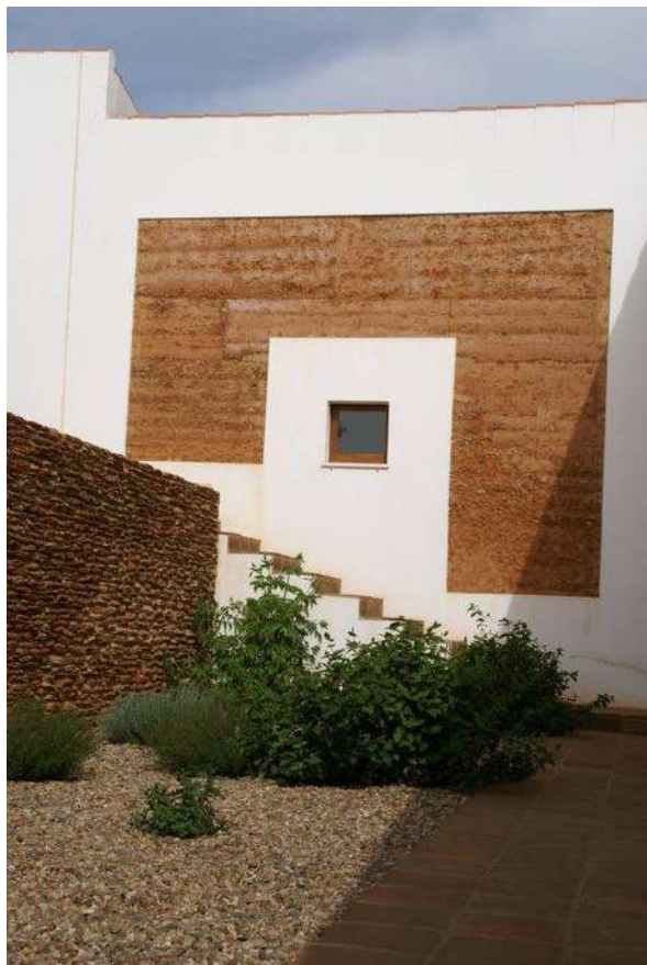
Figura 80 - Parede em taipa exposta e cerâmica de terracota
