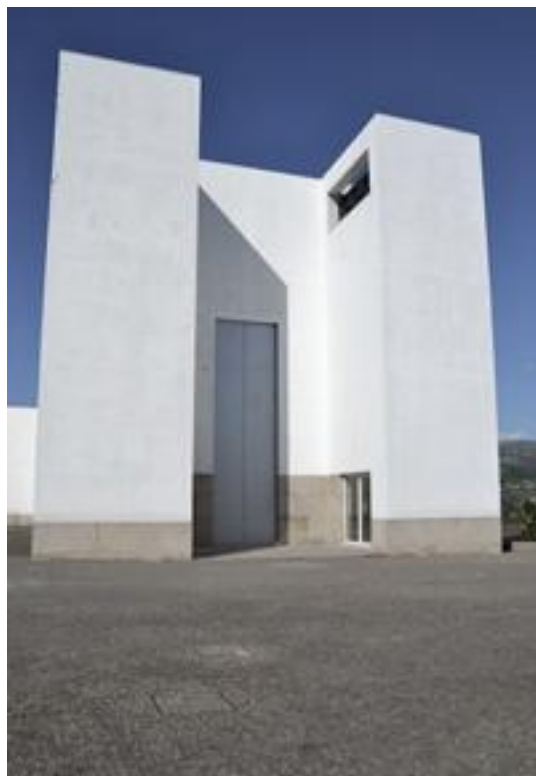
Ilustração 76 - Igreja Santa Maria, Fachada Sudoeste (ilustração nossa, 2017).
