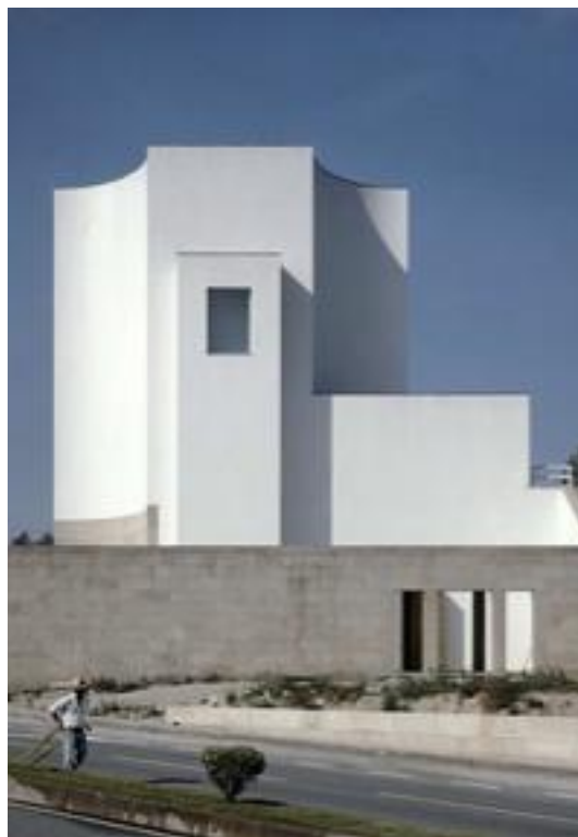
Ilustração 77 - Igreja Santa Maria, Fachada Nordeste (ilustração nossa, 2017).
