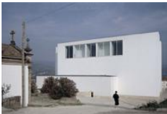
Ilustração 72 - Igreja Santa Maria, Fachada Noroeste (ilustração nossa, 2017).
