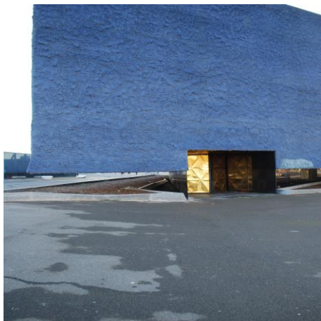
Ilustração 46 - Edifício Fórum. (Ilustração nossa, 2017).
