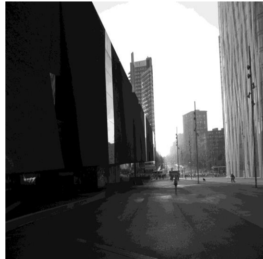
Ilustração 58 - Edifício Fórum. (Ilustração nossa, 2017)
