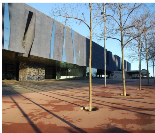
Ilustração 43 - Edifício Fórum. (Ilustração nossa, 2017)
