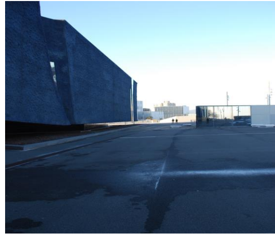
Ilustração 49 - Edifício Fórum. (Ilustração nossa, 2017).
