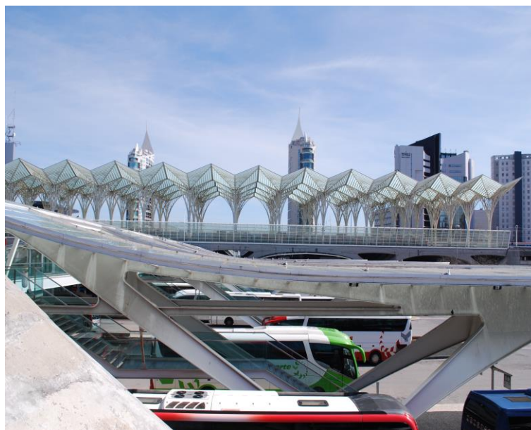
Ilustração 11 - Transportes e Vias de comunicação na zona da Expo 98. (Ilustração nossa, 2017)
