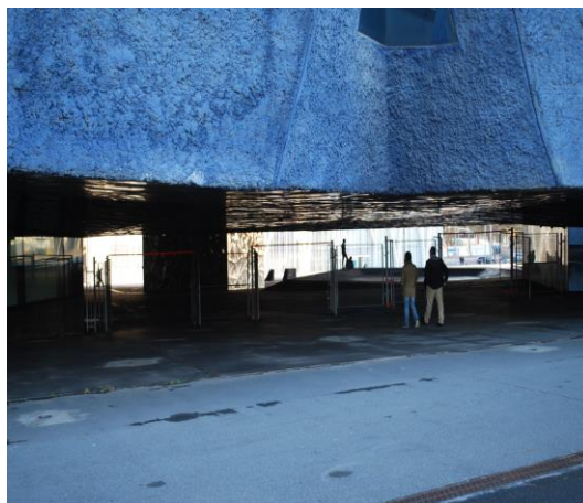
Ilustração 45 - Edifício Fórum. (Ilustração nossa, 2017)
