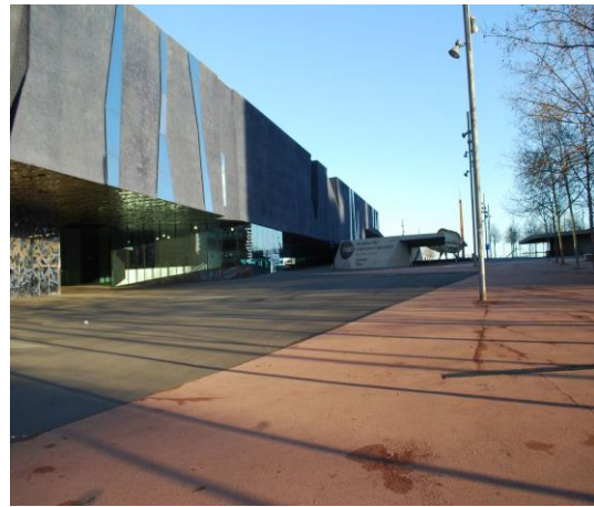
Ilustração 42 - Edifício Fórum. (Ilustração nossa, 2017)
