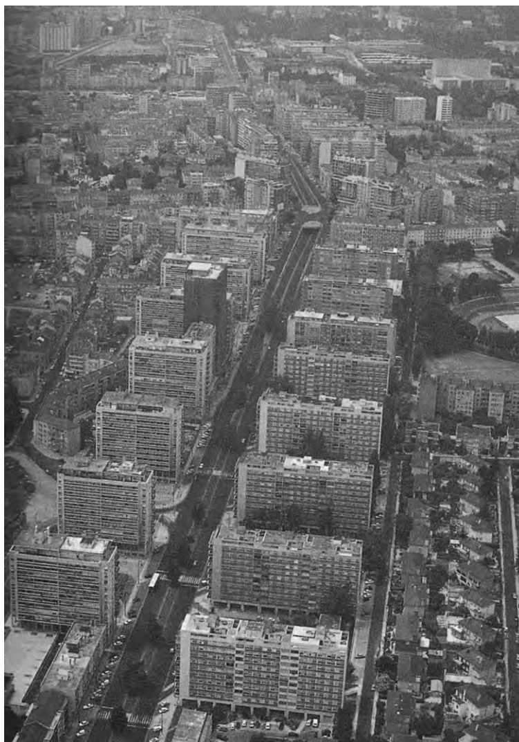
Ilustração 22 – “Vista aérea do bairro de Alvalade (plano de Faria da Costa, 1948), mostrando diversidade tipológica do programa social, expresso na arquitectura. Coexistem os «blocos em altura» característicos da «Carta de Atenas» corbusiana (propagada pela Europa depois da II Guerra Mundial), com as moradias geminadas, ainda vinculadas à «cidade jardim» anglo-saxónica.” (Moita, 1948, p. 503)
