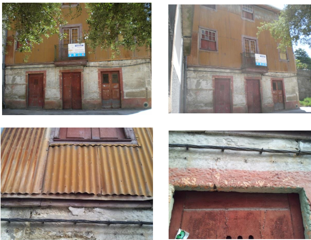
Figura 34 – Aspeto do revestimento exterior (Própria, 2013)
