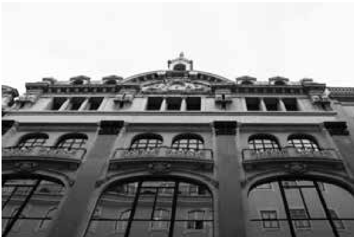
Ilustração 27- Fachada Edifício Grandella (ilustração nossa, 2016).
