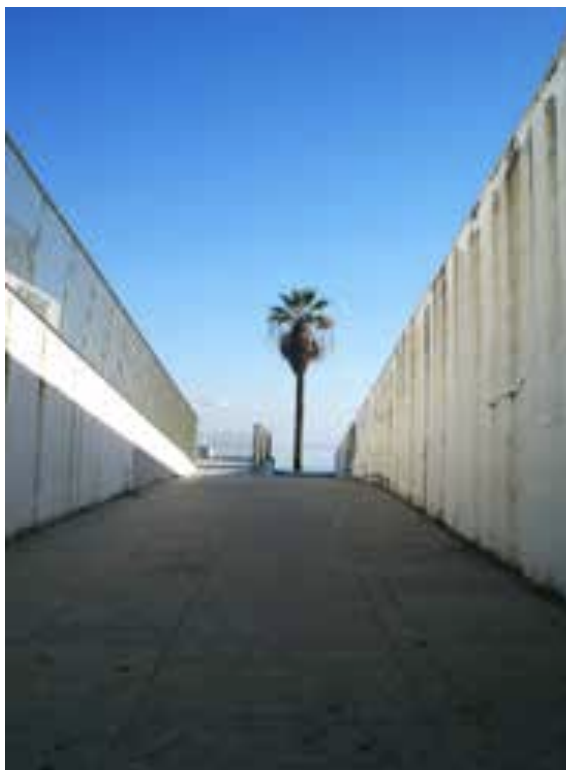
Ilustração 22 - Patamar das escadas e rampa de acesso ao segundo patamar (Ilustração nossa, 2012)
