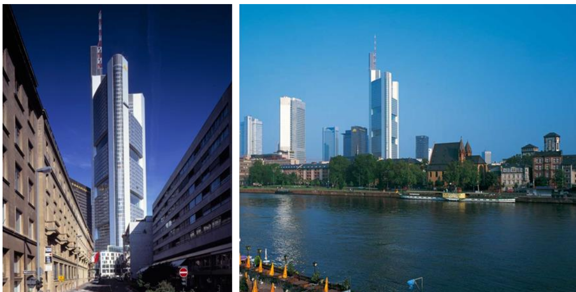
Ilustração 2 - Edifício sede do Commerzbank em Frankfurt (Norman Foster and Partners, 1997)
