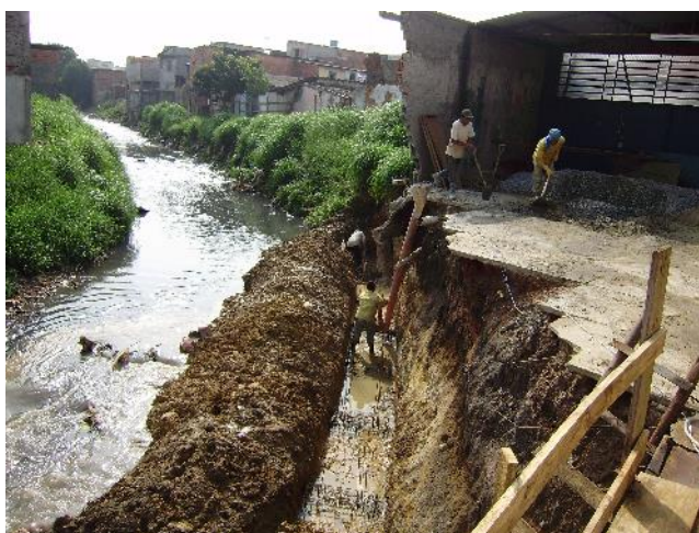
Figura 2: Trabalhos junto a linhas de água.
