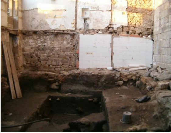
Figura 22: Área de Escavação
