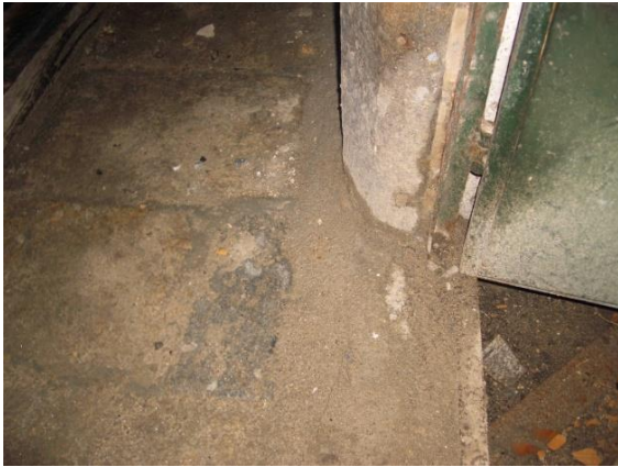
Figura 32: Argamassa sobre o passeio e a soleira
