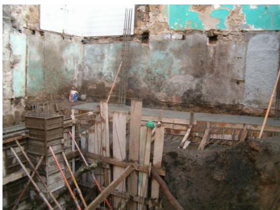
Figura 36: Cofragem do pilar e entivação
