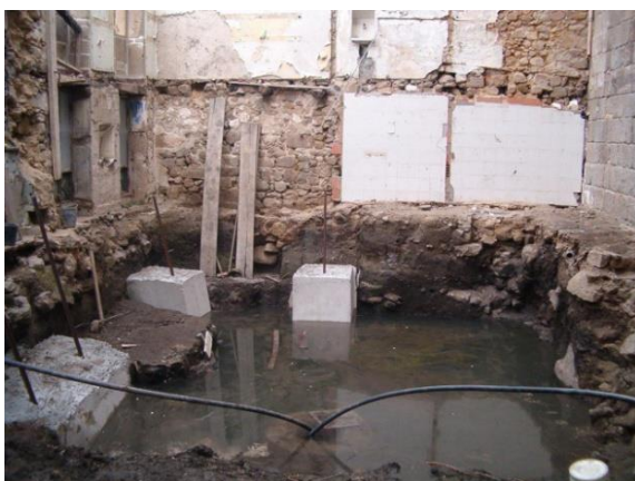
Figura 26: Inundação ainda em fase de escavações
