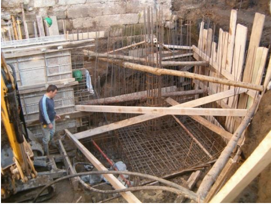
Figura 34: Preparação da armadura de ferro
