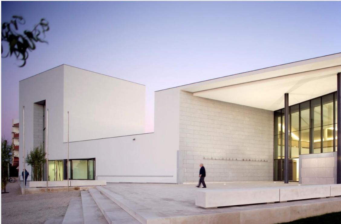
Fig. 12 – Fachada com a torre anexa biblioteca/fórum da juventude
