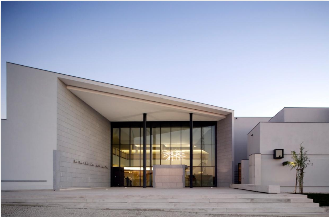
Fig. 16 – Entrada principal da biblioteca orientada a sudoeste e noroeste
