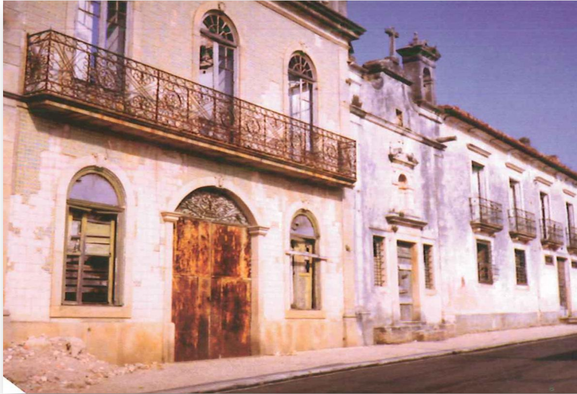
Fig. 10 – Fachada principal (sudeste) do solar e capela em ruínas
