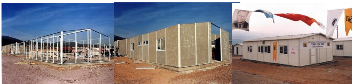
Figura 27 - Assentamentos temporários e pré-fabricados. Bolu, Turquia.
