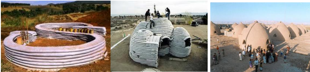
Figura 24 - A construção de uma unidade Super Adobe”, Naderhalili.
