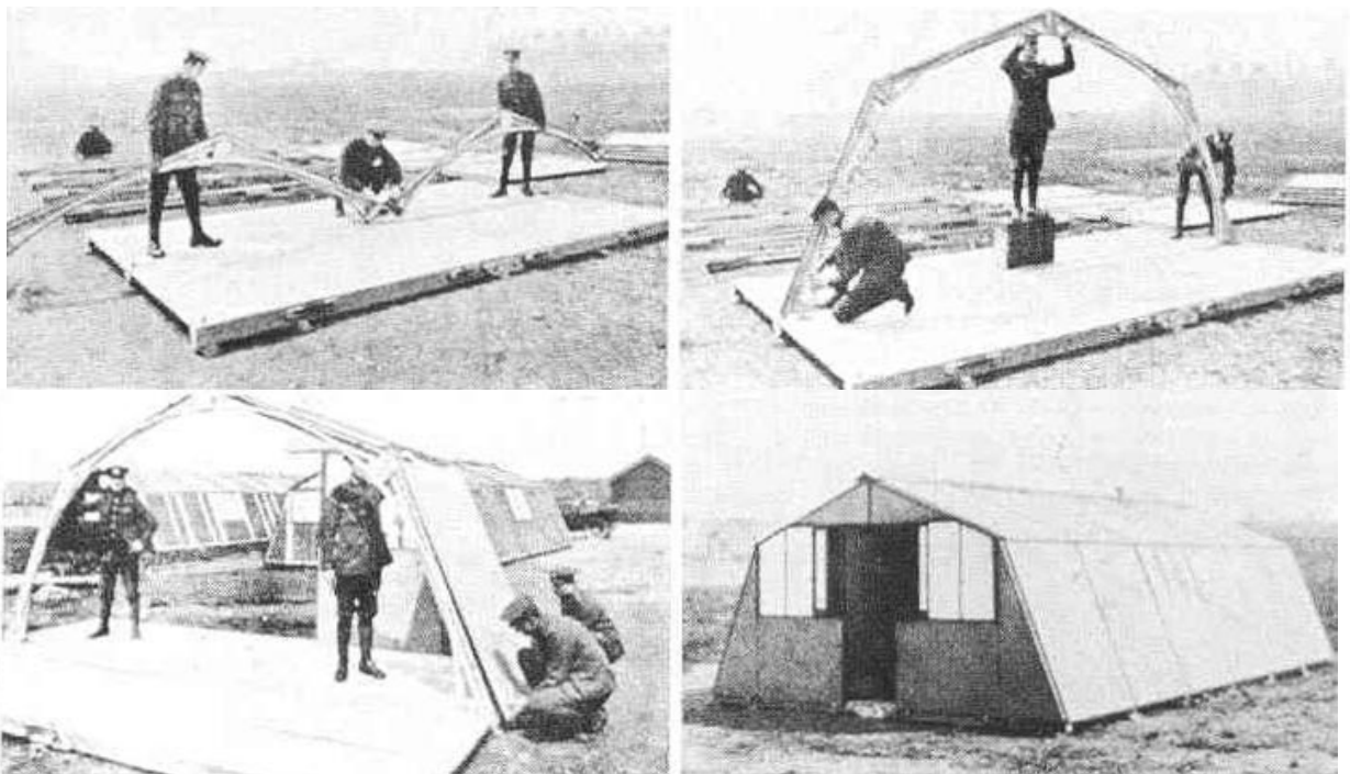
Figura 12 - - Montagem da tenda - "Weblee Portable Hut"
