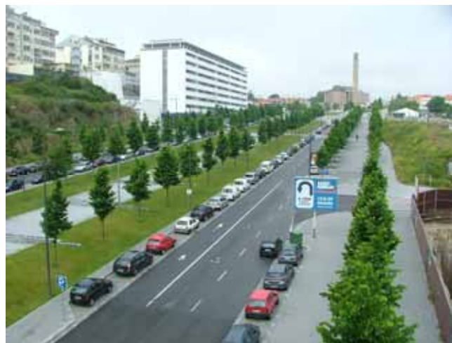
Figura 17 – Alameda da Antas, vista da margem direita.
