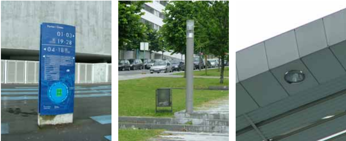
Figura 21 – Equipamento urbano existente (painel de informação e sistemas de iluminação).
