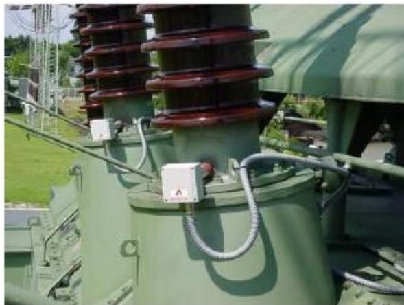
**Figura 64:** Sensor de tensão instalado nas travessias [91].
