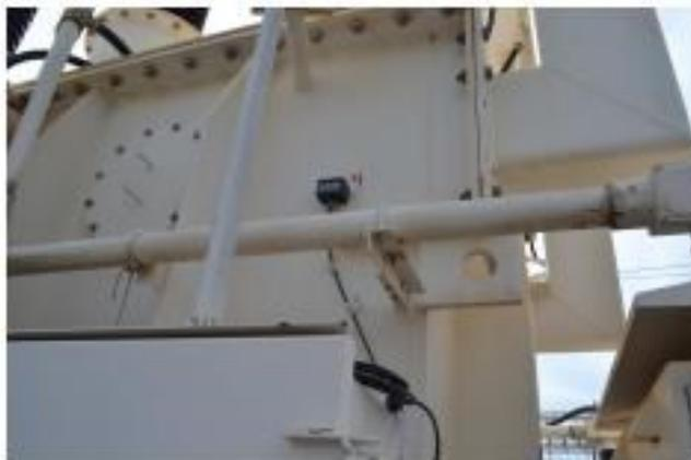
**Figura 65:** Sensor piezelétrico acoplado ao tanque de um transformador [95].
