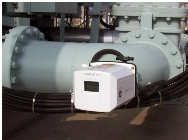
**Figura 62:** Monitorização de gases e humidade num transformador de potência [77].
