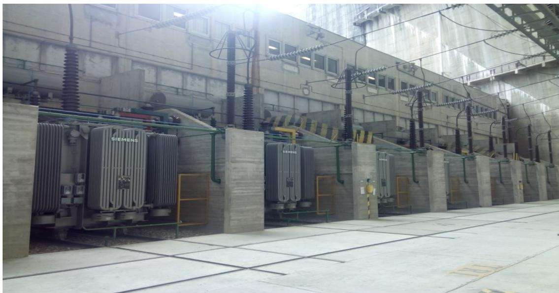
**Figura 1:** Transformadores elevadores da subestação da Aguieira 15/220kV (EDP).
