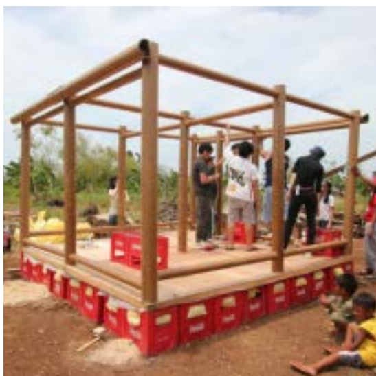
Ilustração 81 – Processo construtivo dos módulos. ([Adaptada a partir de:] McQuaid, 2003).
