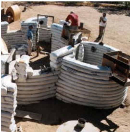
Ilustração 94 – Desenvolvimento da estrutura do módulo. ([Adaptada a partir de:] Stevenson, 2004).
