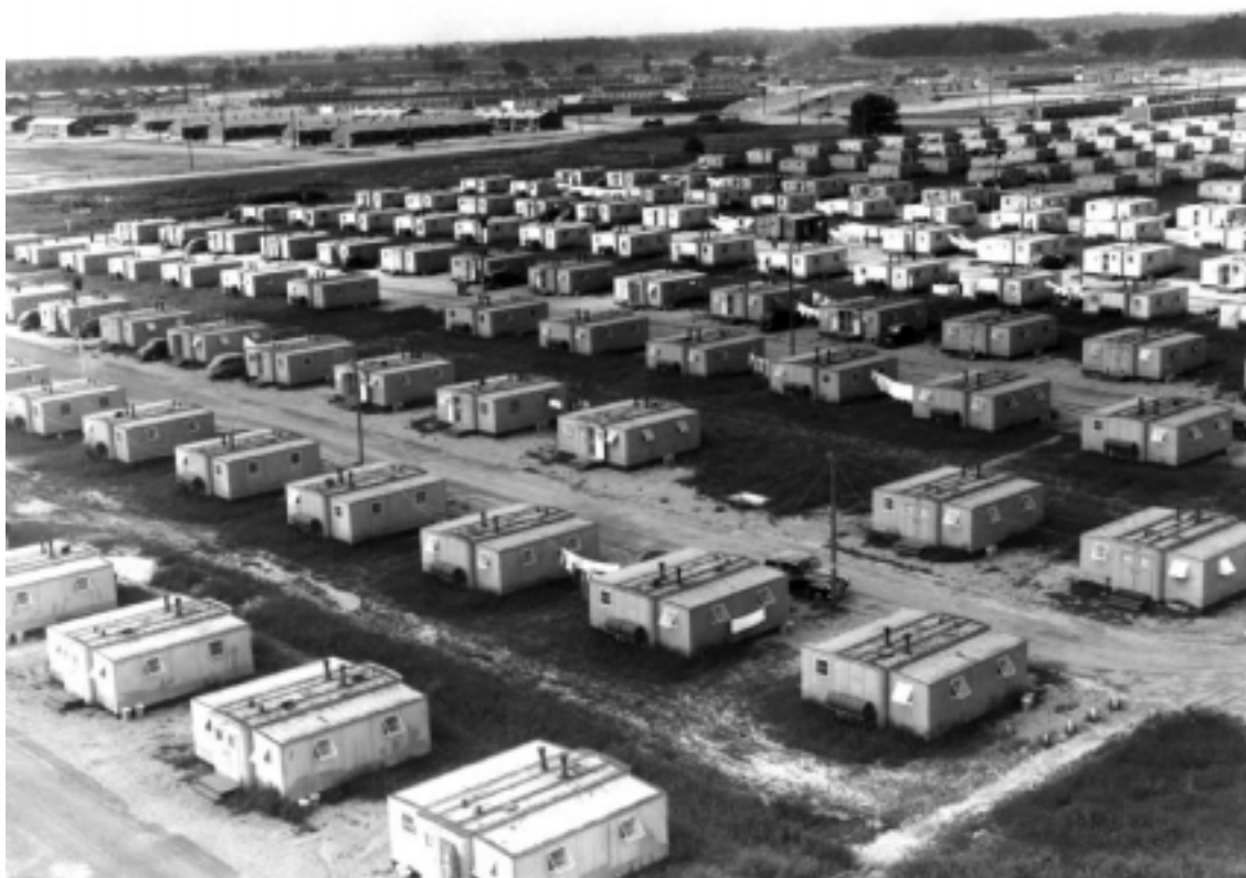
Ilustração 9 – Conjunto habitacional em módulos pré-fabricados do início do século XX, Estados Unidos. ([Adaptada a partir de:] MyCapture, 2011).
