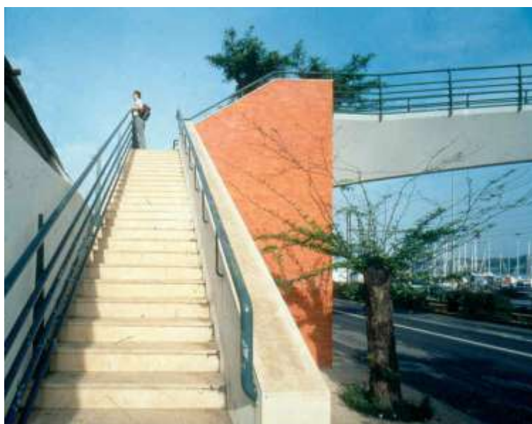
Ilustração 62 – Perspectiva ao acesso Norte á estrutura de atravessamento. (Tainha, fotografia cedida por Manuel Tainha, 1993)
