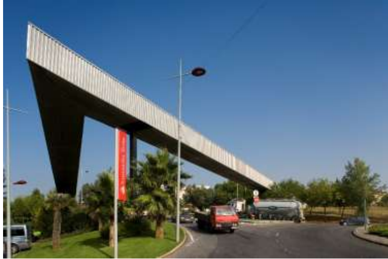
Ilustração 82 - Perspectiva exterior e inferior do ponto de união do sistema de rampas. (Arruda, fotografia cedida por Miguel Arruda, 2012)
