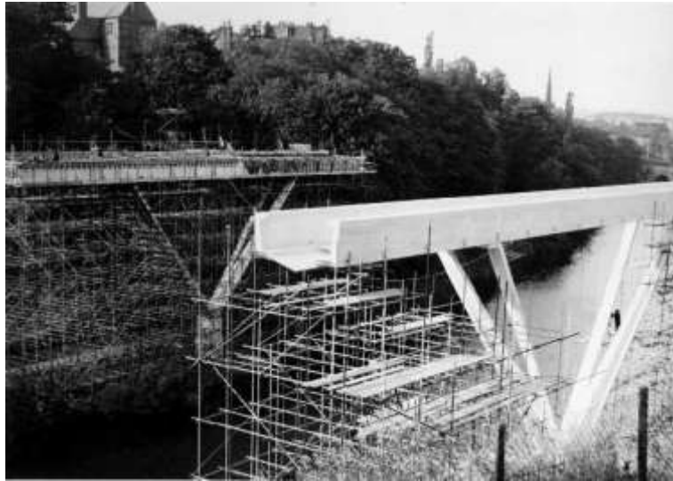
Ilustração 45 – Montagem em duas partes nas encostas do rio. (Nan, 2011)
