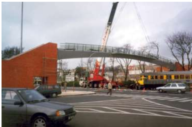
Ilustração 59 - Posicionamento da estrutura metálica, sem interrupção da circulação ferroviária e automóvel. (Tainha, fotografia cedida por Manuel Tainha, 1992-1993)
