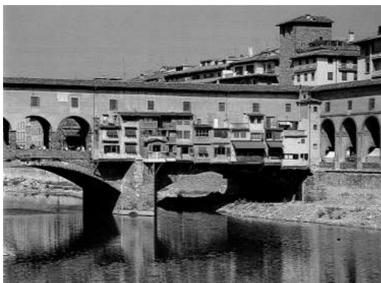
Ilustração 23 – Ponte Vecchio em Florença, construção de 1345. A galeria suporta pequenas lojas de ourives. (Bennett, 1999, p. 19)
