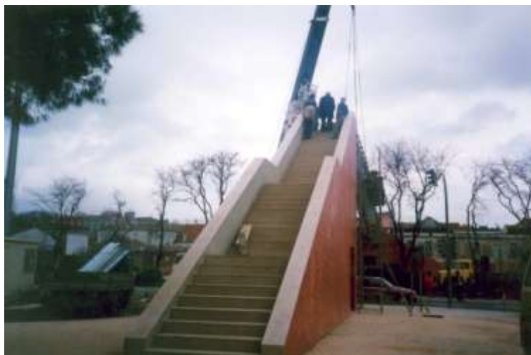
Ilustração 64 - Perspectiva do acesso Sul. Colocação da estrutura metálica com sobrevisão da equipa técnica de projecto. (Tainha, fotografia cedida por Manuel Tainha, 1992-1993)
