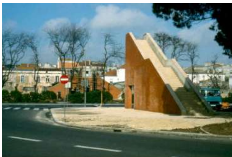
Ilustração 65 – Perspectiva do acesso Sul em fase de conclusão. (Tainha, fotografia cedida por Manuel Tainha, 1992-1993)
