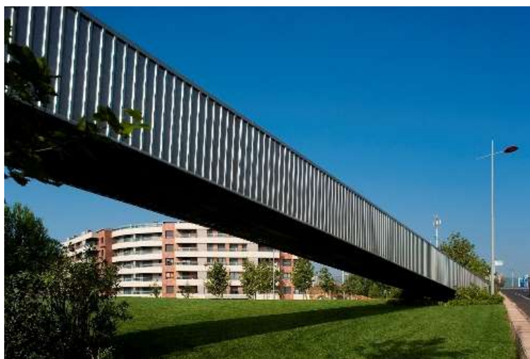
Ilustração 85 - Perspectiva exterior de um dos pontos de contacto da estrutura com o solo, (Arruda, fotografia cedida por Miguel Arruda, 2012)
