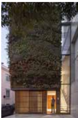
Ilustração 47 – Fachada lateral. (FG+SG, 2012)
