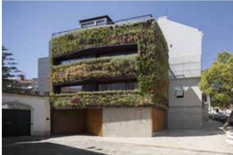
Ilustração 46 – Fachada principal. (FG+SG, 2012)
