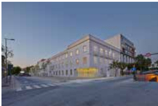
Ilustração 116 – Exterior do edifício. (Carvalho Araújo H. , 201?)
