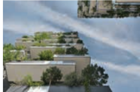
Ilustração 91 – Vista inferior dos edifícios. (Stevens, 2014)
