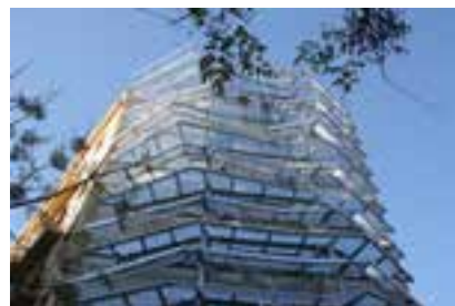
Ilustração 114 – Estrutura metálica. (Mazzocchi, 2012)
