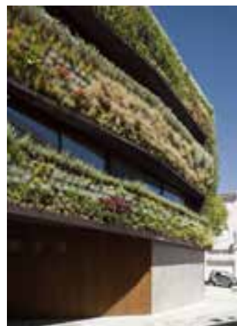
Ilustração 48 – Fachada principal. (FG+SG, 2012)
