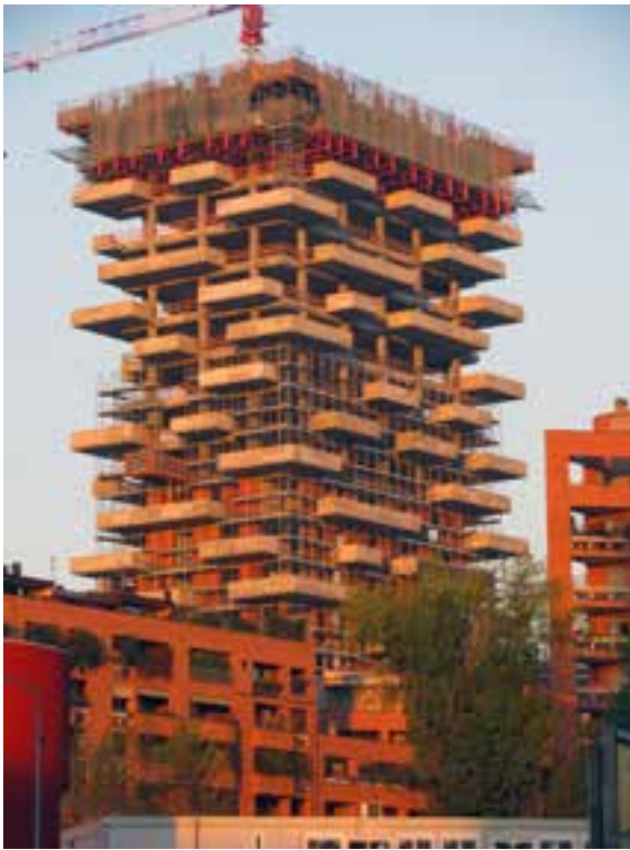
Ilustração 78 – Uma das Torres em Construção. (CTBUH, s.d.)
