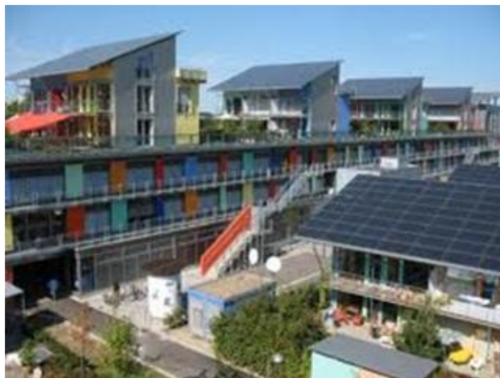
Ilustração 21 - Telhados fotovoltaicos no Japão. (Google Photos 2013)
