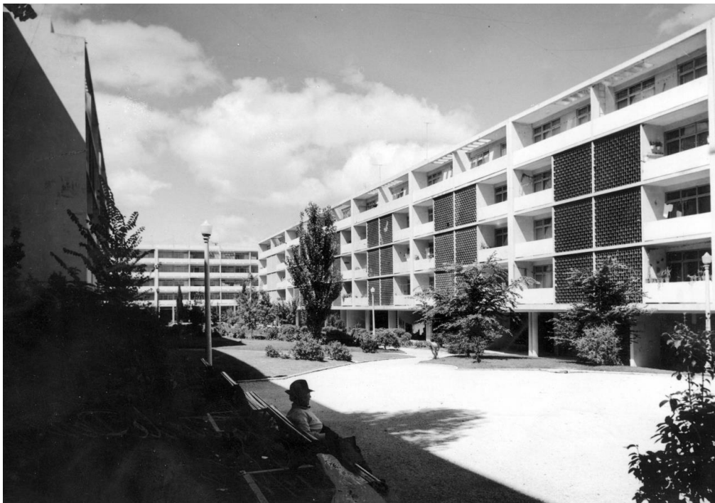
Ilustração 13 - Logradouro, Bairro de São João de Deus, também conhecido por Bairro das Estacas, 1958. (Seródio, 1958).
