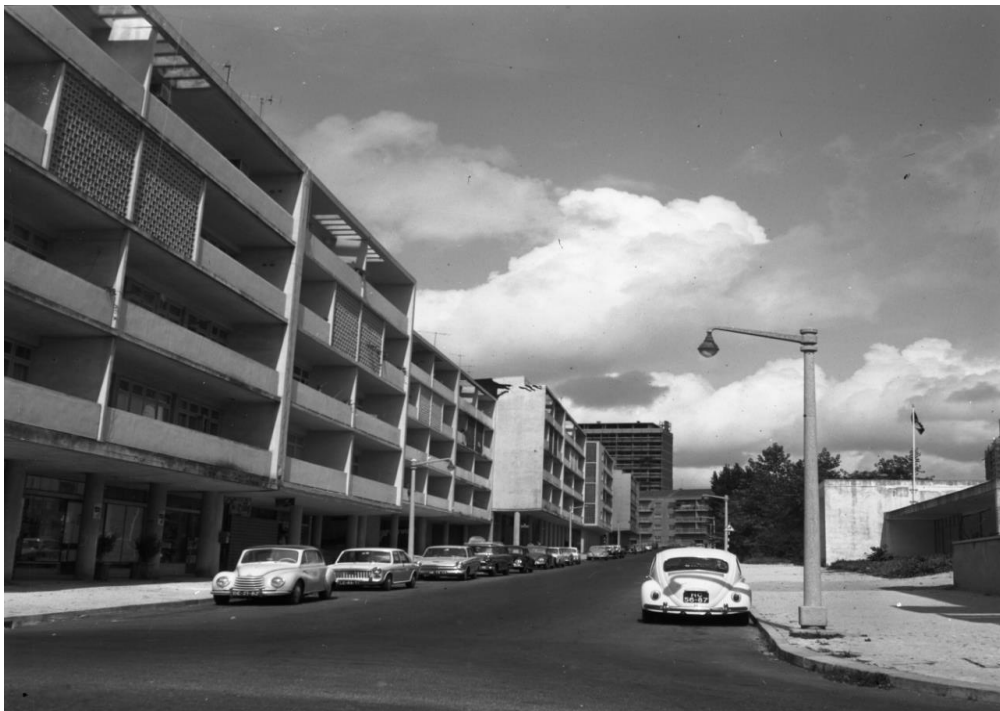
Ilustração 11 - Rua Teixeira Pascoais, Bairro das Estacas, 1967. (Fernandes, 1967a)
