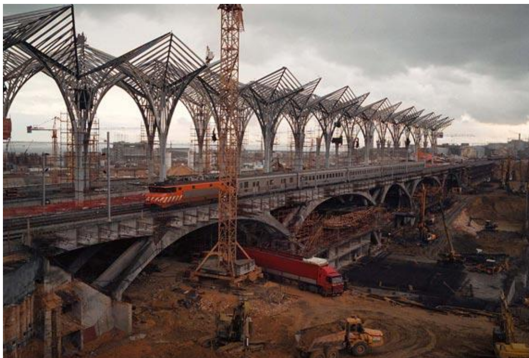
Ilustração 15 - Obras de construção da Gare do Oriente. (Bruno Peres, 1997)
