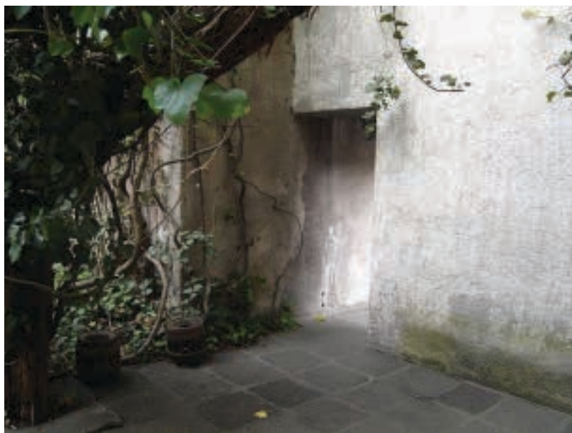
Ilustração 47 – Casa-Atelier Luís Barragán: Passagem entre o jardim cercado e o pátio, Luís Barragán, 1948. (Sveiven, 2011).
